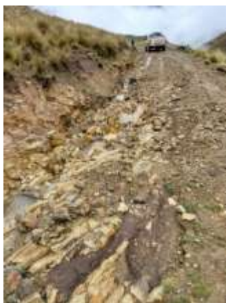
Imagen 1. Vista parcial de la vía de acceso hacia la obra de toma del sistema de riego Torre Torre.
